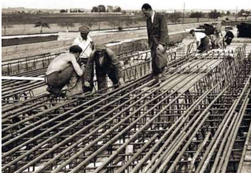
Obrázok 64 Ručné armovanie premostenia. Cez vojnu bol veľký nedostatok stavebnej ocele.
