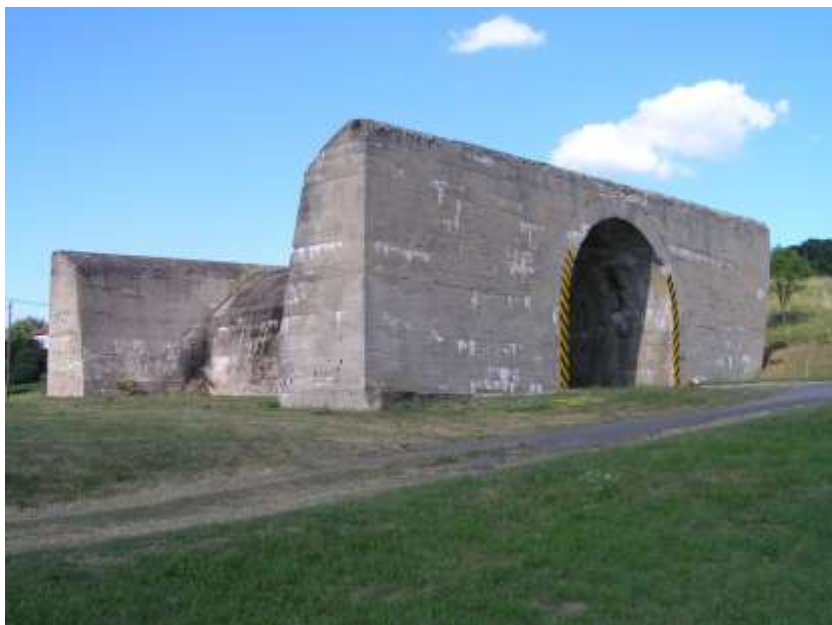
Obrázok 56 Stavebné diela sa budovali v predstihu... súčasný stav.
