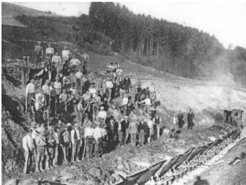
Obrázok 66 To je tých 600 chlapov na 5 km, alebo ručné odkopy a svahovanie zárezu.
