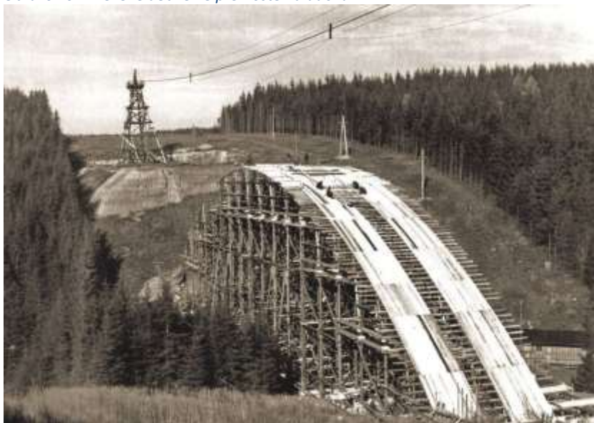
Obrázok 63 Všetko ručná robota stavebných tesárov. Nádherný oblúk premostenia údolia. Tesárska konštrukcia debnenie
