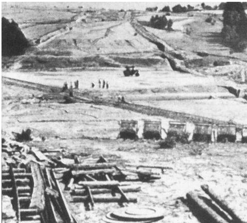
Obrázok 58 Stavba cestného telesa, väčšina prác ručne, presun hmôt vagónikmi a poľnou lokomotívou. V pozadí jeden cestný valec.
