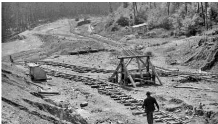
Obrázok 60 Od roku 1942 sa práce na výstavbe diaľnice zastavili, bol tam len jeden strážca a v noci nočný vartáš - strážnik.
